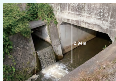
橋梁の高さの計測例(1点と面の最短距離)
