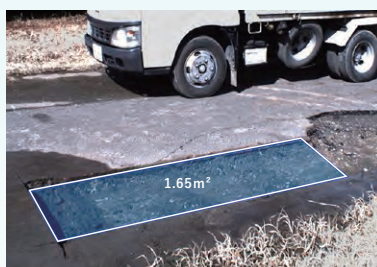
掘削面積の計測例(面積)
