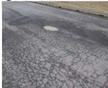
①表層が損傷している状況
